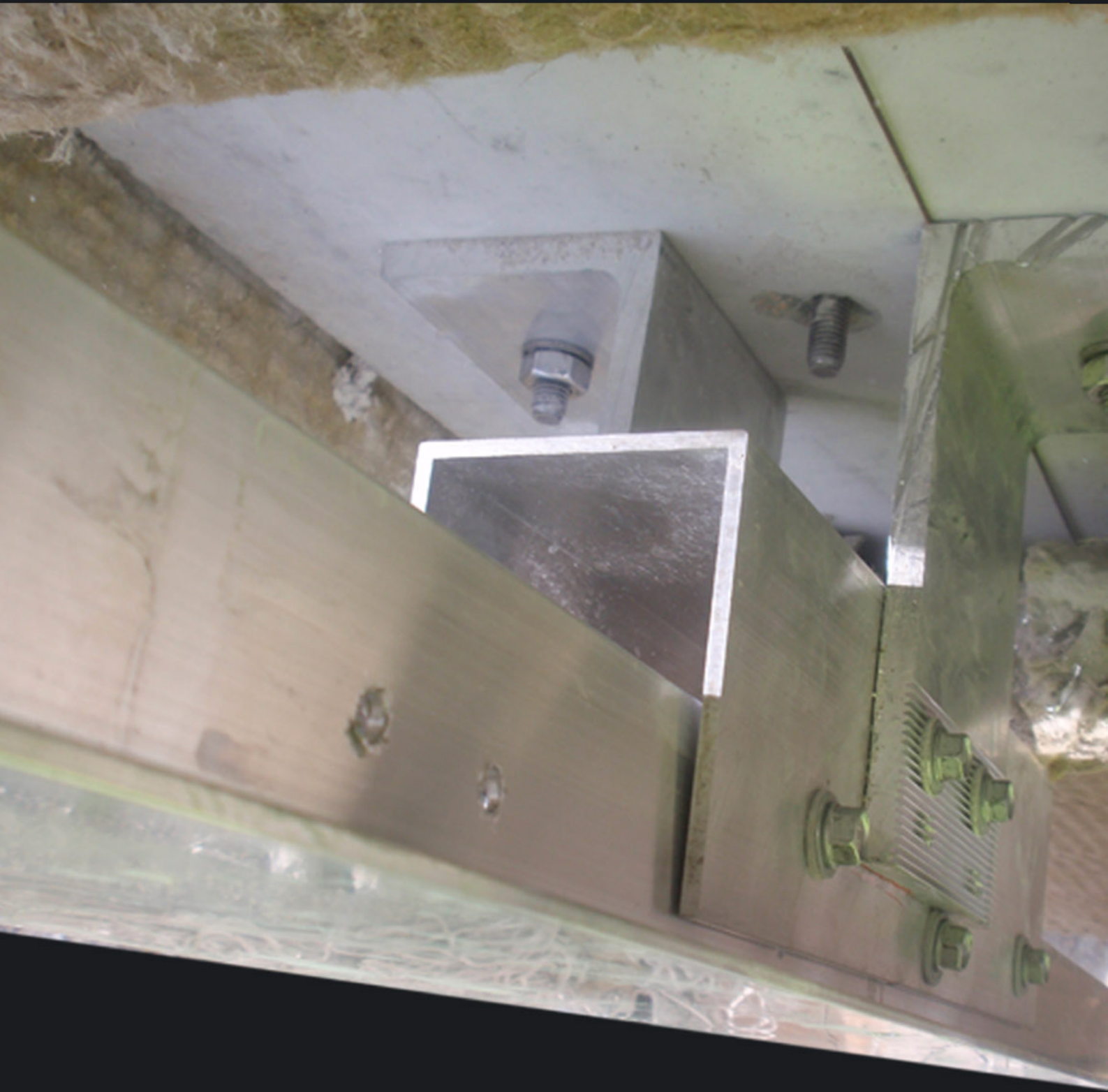
Sistema estructural para cámaras superiores a 170 mm.
