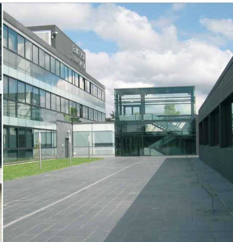
Edificio: I+D Zamudio. Bizkaia
